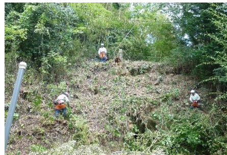
<伐採後の様子>
